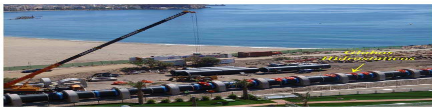
Fotografía 3 Montaje de globos hidrostáticos en el tramo de inmisario submarino que se encuentra construido en la "lanzadera".
