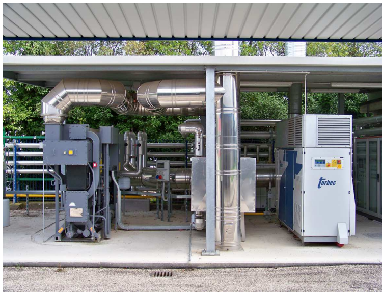
Fig. 29. Trigeneration plant
